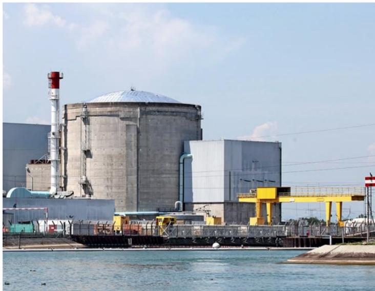
Au cœur de l'enceinte en béton, grâce à la chaleur du circuit primaire, le générateur transforme l'eau du circuit secondaire en vapeur pour alimenter les turbines produisant l'électricité. PHOTO ARCHIVES DNA
