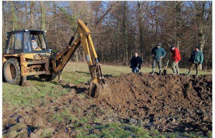
Cinq mares à batraciens sont désormais en place. Les deux nouvelles ne devraient être colonisées que d'ici trois ans. PHOTO DNA
