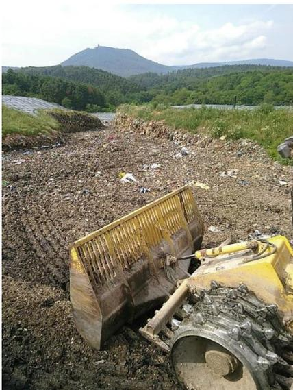
Les déchets sont compactés au maximum grâce à un engin de 40 tonnes muni de « pieds de moutons » afin d'éliminer les poches d'air.
